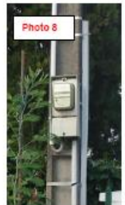
Compteur extérieur apparent
